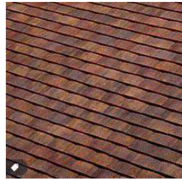
Tuiles de terre cuite plates de teinte brun-rouge à pureau longitudinal
